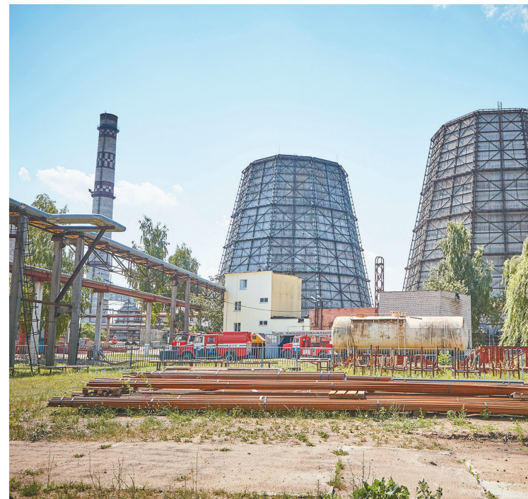
Реконструкция Минской ТЭЦ-3
